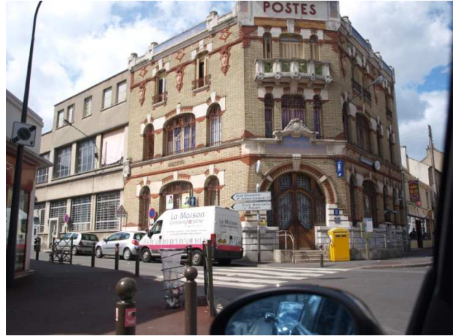
La Poste située dans la rue de la résidence.
