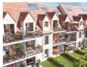
Le Clos du Parc Beauvais (60)
